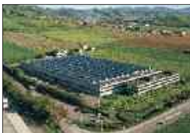
Beghelli S.p.a. Monteveglio, Italy
